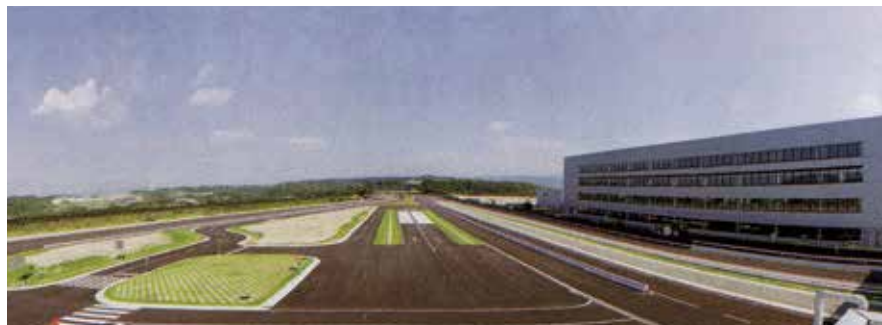
波状路、石畳など13種類の様々な路面を持つ走行確認路
