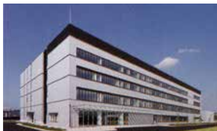
4階建てで、床面積約17,600m 2 の研修棟
