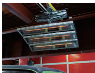
最新鋭の塗装ブースになり作業環境が向上。ブースの横には、大型の吊り下げ式カーボンヒーターが設置されている
