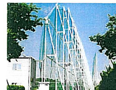
【沖浦ゴルフセンター鉄骨】 3種ケレン/ラストボンドSG/カーボマスチックカラー-11/カーボライン134HS
