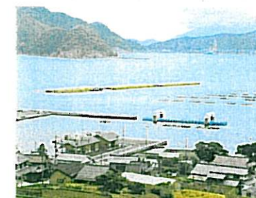
【高浜町浮消波堤】 3種ケレン/ラストボンドSG/カーボマスチック15/カーボマスチックカラー-11/シロキサンエースHB
